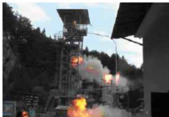
Abb. 2: Malzstaubexplosion in einem druckentlasteten Elevator. Druckentlastungsöffnungen im Elevatorfuß, -kopf und in den Elevatorschächten.
